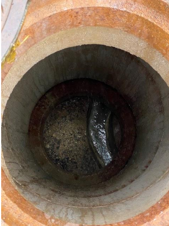
Dagvattenbrunn i brunnpar:3. Inga avvikelser noterades.
